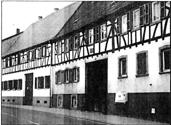
Abb. Zweigeschossige Fachwerkgebäude in der Hauptstraße
