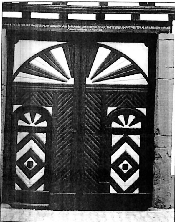
Abb.: Historisches Haustor mit Sandstein-Gewänden
