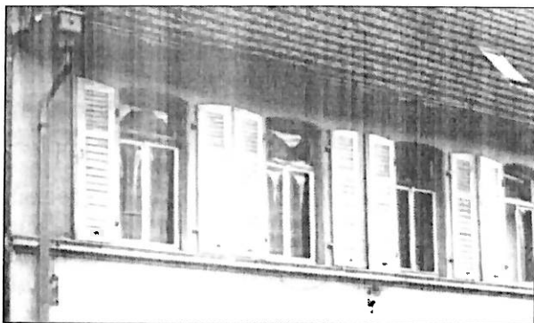
Abb.: Zweiflügelige Fenster mit Oberlicht, Klappläden
