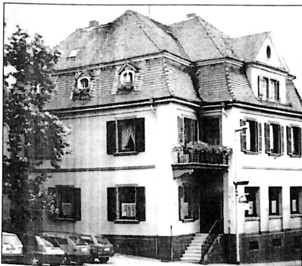
Abb.: Mansarddach mit Ziegeleindeckung
