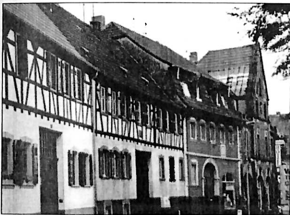
Abb.: Geringe Dachüberstände, vor der Fassade liegende Regenfallrohre
