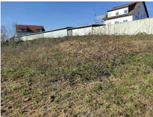
Böschung im nordwestlichen Bereich (Datum: 20.02.2023)
