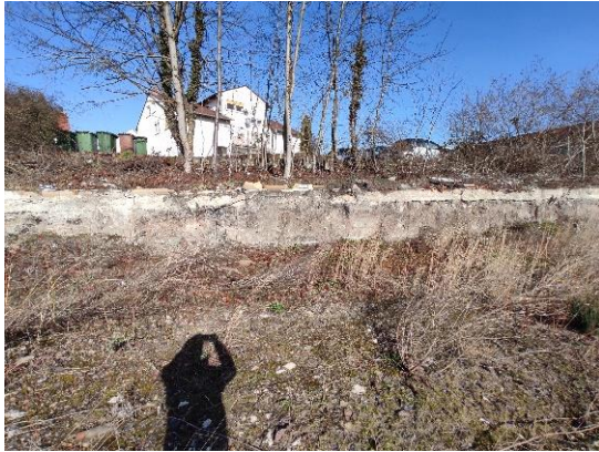
„Abbruchkante“ und Gehölze nördlich der Bebauung (Datum: 20.02.2023)
