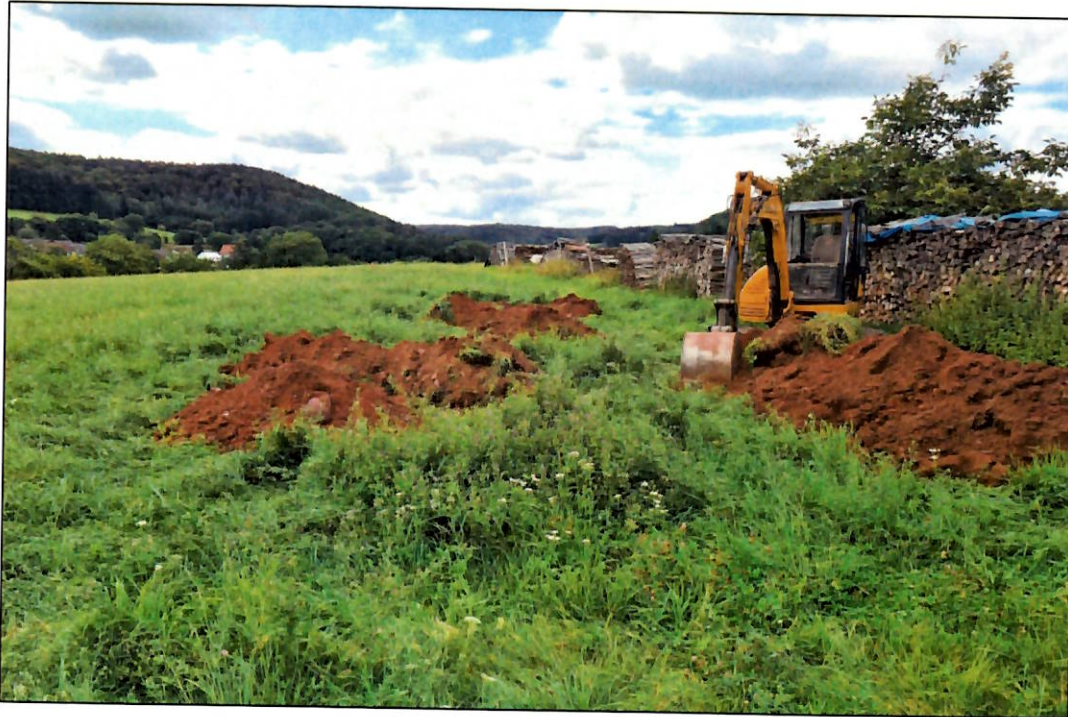
Abbildung 2: Projektareal während der Schurfarbeiten
